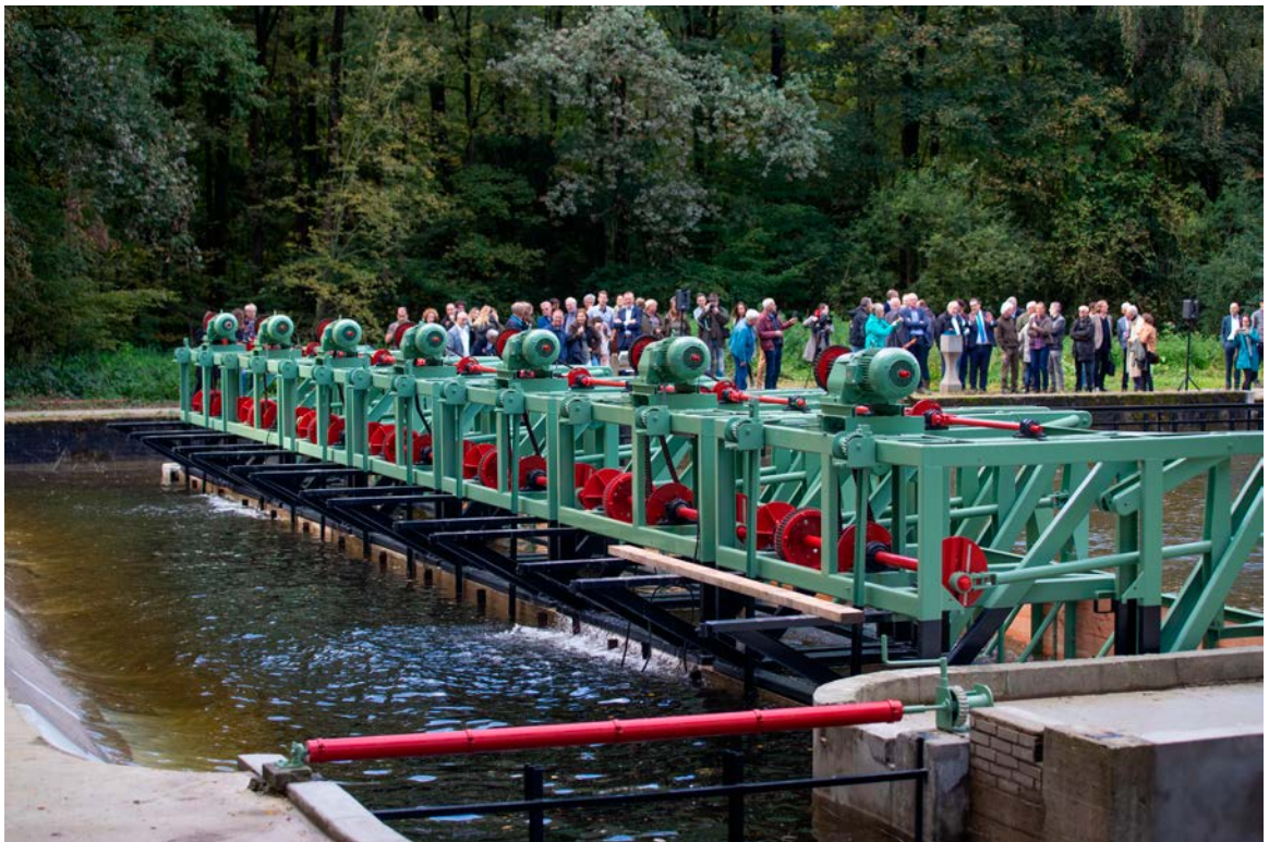
Het waterloopkundig laboratorium in het Waterloopbos in de Noordoostpolder waar ingenieurs tussen 1951 en 1996 modellen bouwden van waterwerken. Met deze golfbak werd de invloed getest van golven op dijken en op een grindstrand. De Golfbak legde een basis voor de Deltawerken en andere waterstaatkundige projecten. In dit 'laboratorium' is een groot deel van de waterkundige kennis ontwikkeld die Nederland nog steeds exporteert. Foto: Fotografie Freddy Schinkel
