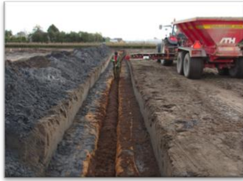
Figuur 9. Met ijzertzand omhulde drain
